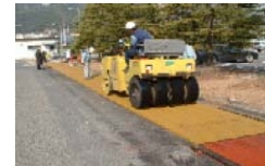
色彩性、施工性に富んだCSファルトによる舗装工事
