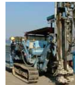
VOC浄化のためのRNIP施工方法(例)
