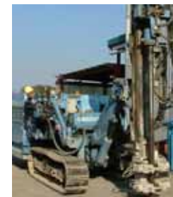
VOC浄化のためのRNIP施工方法(例)
