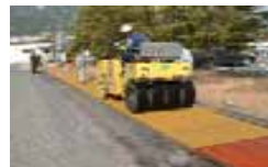
色彩性、施工性に富んだ「CSアスファルト」による舗装工事
