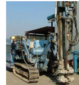
VOC浄化のためのRNIP施工方法(例)
