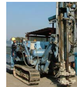
VOC浄化のためのRNIP施工方法(例)
