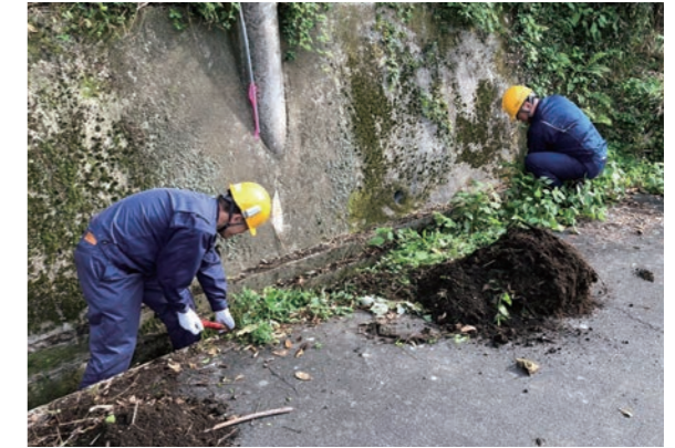
戸田ピグメント近隣県道側溝の泥上げ
