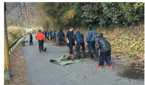
道路側溝の清掃活動
