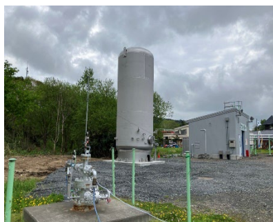
坑井（手前）と新設ガスタンク
