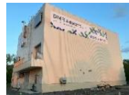
CO 2 フリー水素製造プラント
